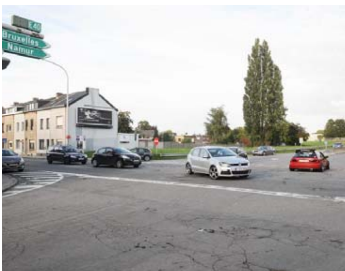
Une sécurisation et une rénovation nécessaires.
